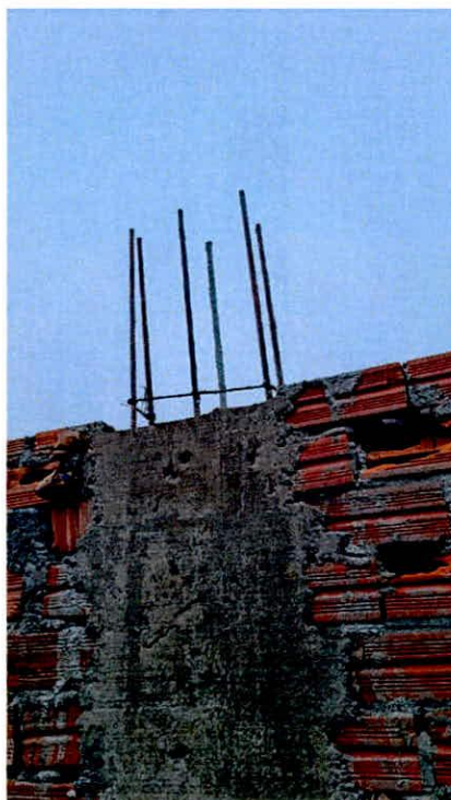
Pilar com 6 barras de aço 10mm conforme projeto
